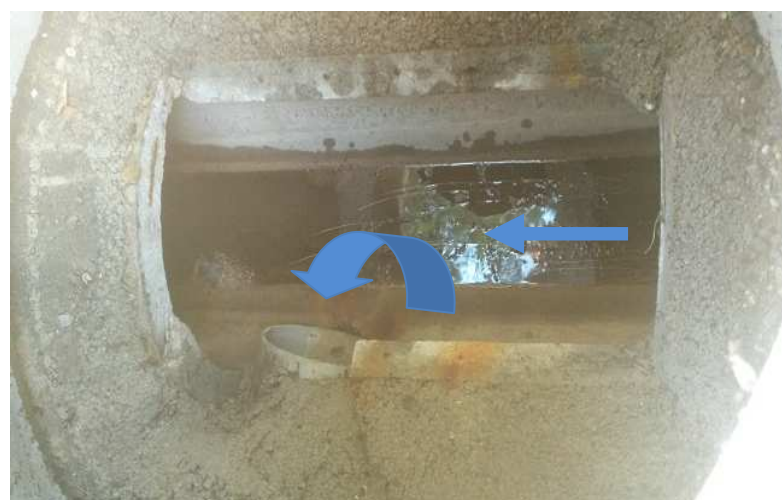
Photographie n°1 : Arrivée des surverses DN 125 PVC
