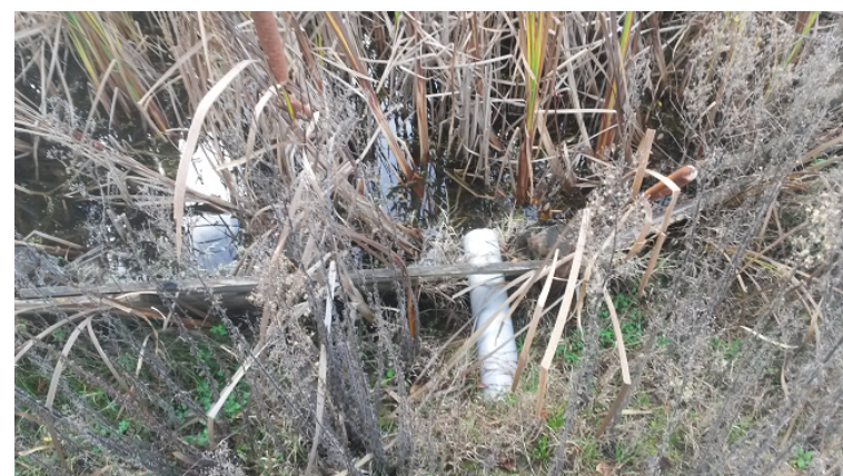
Photographie n°1 : Arrivée des surverses DN 125 PVC
