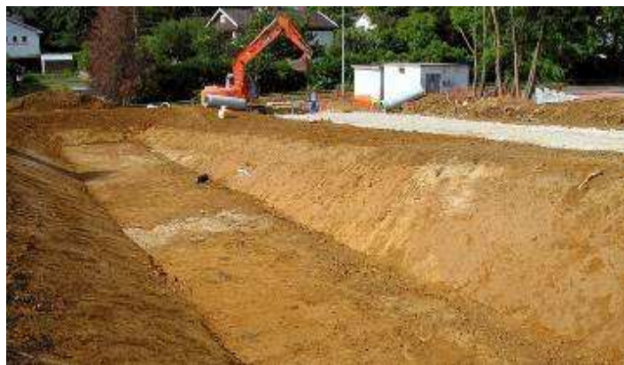
Figure 39 : Exemple de mise en place d'un bassin de rétention des eaux pluviales
