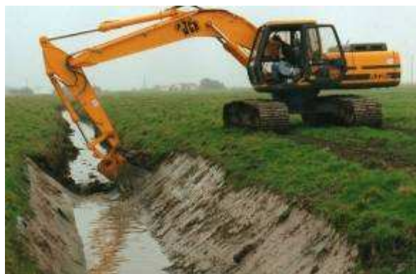
Figure 38 : Exemples de curage et reprofilage de fossé
