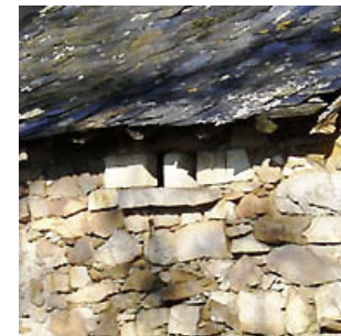
Corniche épannelée et assises de rampant
