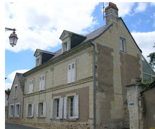
Maison (1860-1870) à façade en appareil de pierre de taille de tuffeau, agrémentée d'éléments décoratifs et, en toiture, de lucarnes à fronton-pignon
