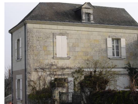
Maison (1860-1870) à façade en appareil de pierre de taille de tuffeau, agrémentée d'éléments décoratifs et, en toiture, de lucarnes à fronton-pignon
