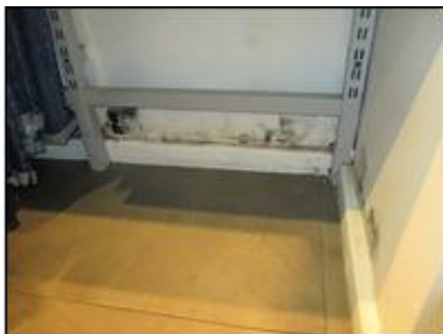
Humidité sur les contreplaqués - Pimkie
