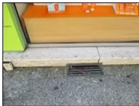
Entrée d'eau par les aérations des caves – Pharmacie des Cordeliers
