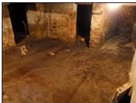
Mur porteur en pierre – sol en terre battue – Du Pareil au même
