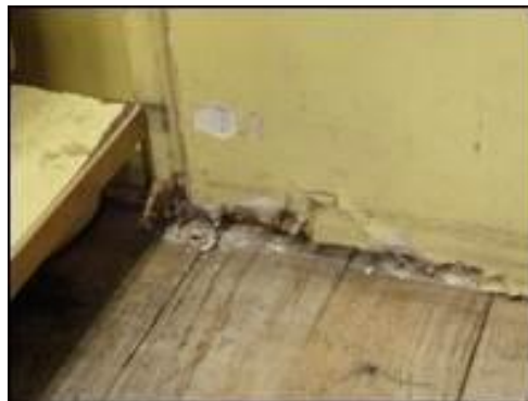
Gonflement des boiseries – écaillage peintures – Du pareil au Mème
