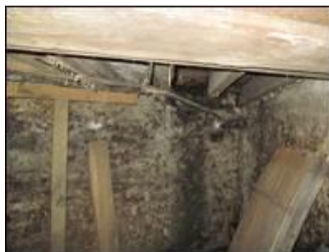
Plancher bois avec poteau de renfort – Bijouterie Gaudin
