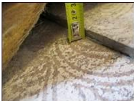
Affaissement plancher - Faibelle
