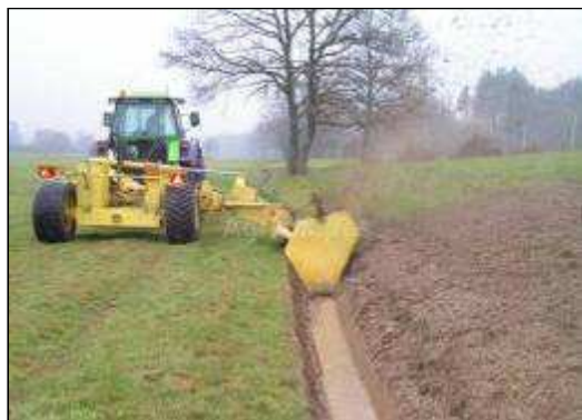
Figure 1 : Exemples de curage et reprofilage de fossé
