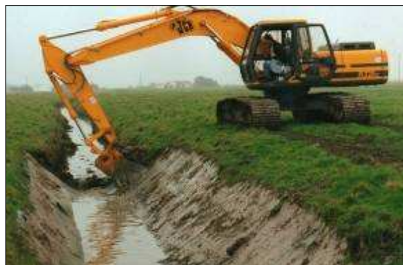
Figure 1 : Exemples de curage et reprofilage de fossé
