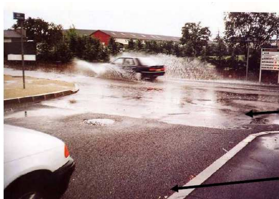
Chaussée à structure réservoir, Craponne (CERTU - 1994)
