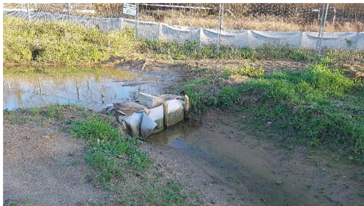
Figure 34 : Exemple de filtre réalisé à l'aide de bottes de paille enveloppées dans un géotextile filtrant (source : ACE 3 , février 2020).
