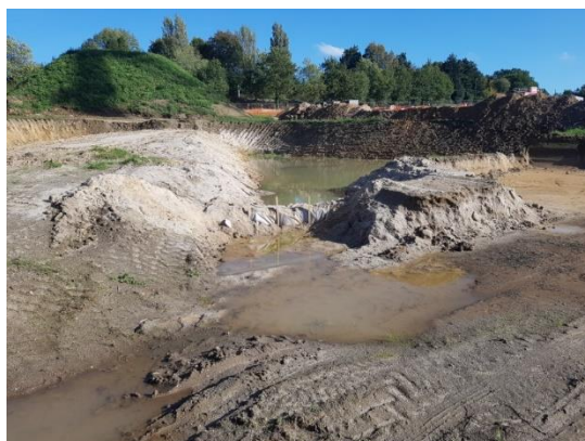
Figure 34 : Exemple de filtre réalisé à l'aide de bottes de paille enveloppées dans un géotextile filtrant (source : ACE 3 , février 2020).
