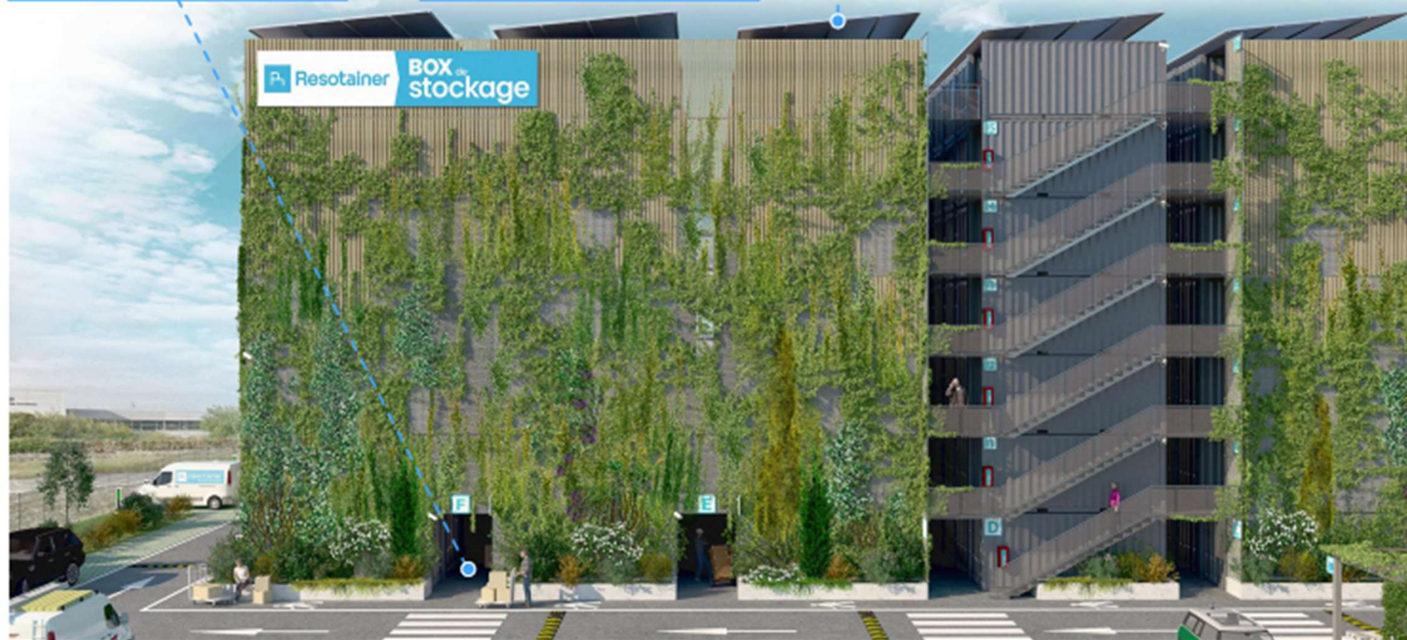
Panneaux photovoltaïques en toiture : Site en autoconsommation 4 106 m 2 d'emprise projetée Hauteur égout : +16m Hauteur faîtiage : +16,55 Pentes de 9%, orientées Sud-Est
