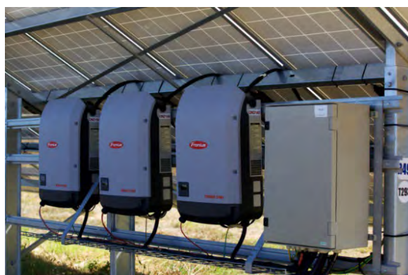
Onduleurs et tableaux électriques
