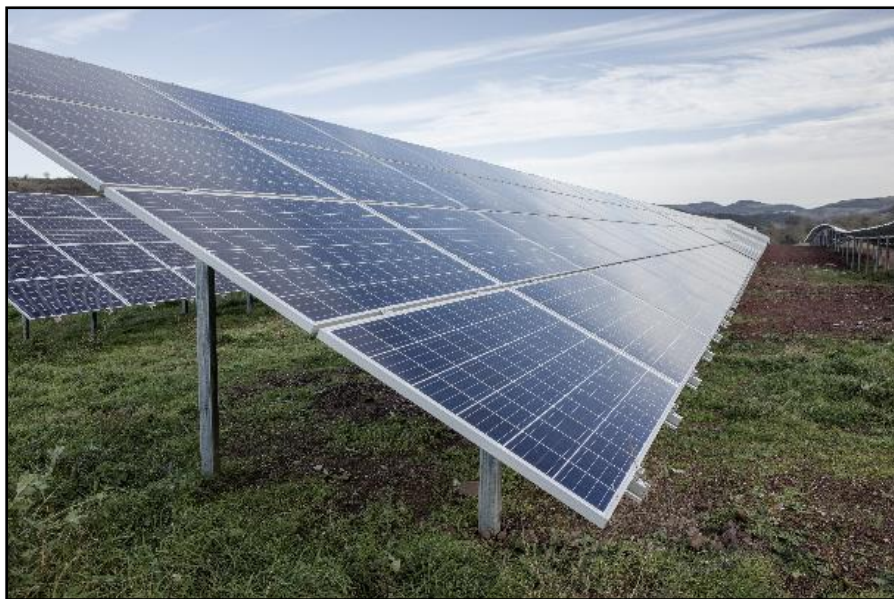
Photo 4 : Structures en pieux battus - Parc Solaire de Camares (12) - SDMD
