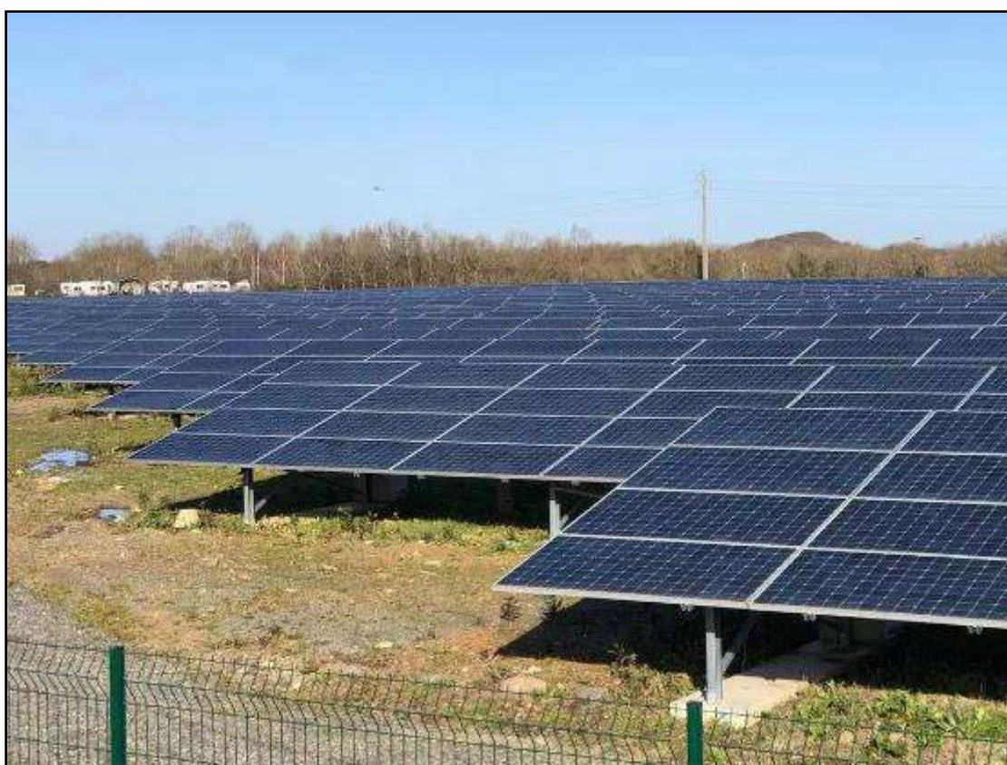
Photo 3 : Structures en longrines béton - Parc Solaire de la Petite Vicomté (Les Ponts-de-Cé (49))
