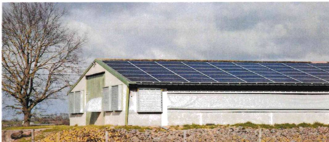
Figure 4 : Rénovation d'un poulailler avec pose de panneaux photovoltaïques en couverture
