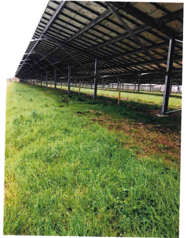
Figure 2 : Volière photovoltaïque : ombrage des oiseaux et préservation des couverts végétaux
