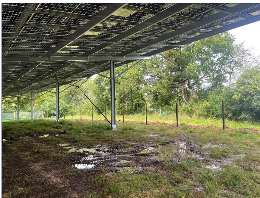
Photo de structures bi pieux sur le projet de Brinon-sur-Sauldre (Source : UNITE)
