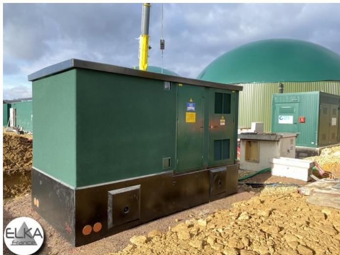
Poste de Transformation/livraison en béton préfabriqué Source : ELKA France
