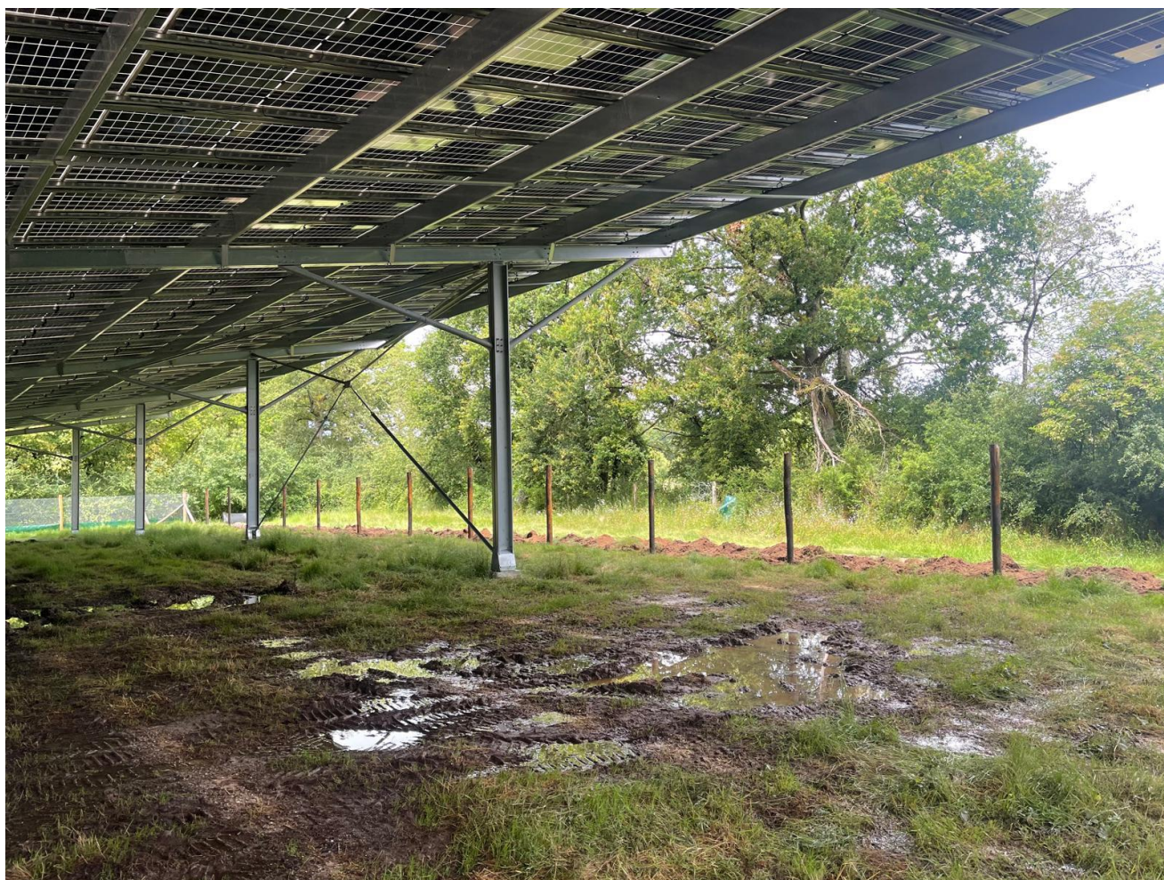
Photo 1 : Exemple d'ombrières photovoltaïques bi-pieux (en cours de construction – Site de Brinon-sur-Sauldre) – Source : UNITE
