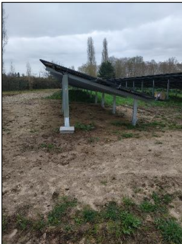
Photo 2 : Tables photovoltaïques avec structures en micropieux - Parc solaire de Soucelles - 299 kWc
