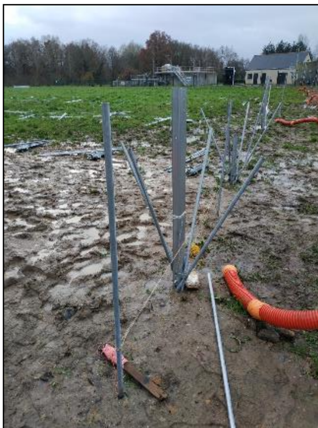
Photo 1 : Structures en micropieux, avant battage des micro-pieux - Parc solaire de Soucelles - 299 kWc
