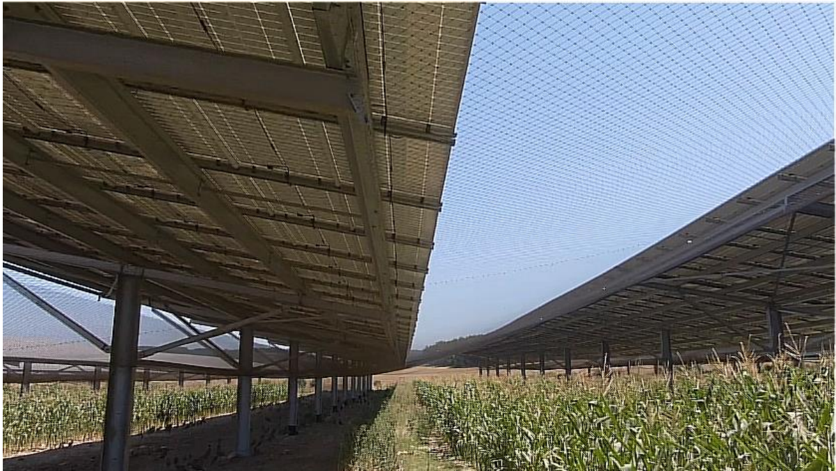
Photographie 3 : Une volière agrivoltaïque développée par Technique Solaire avec l'aménagement du parcours extérieur avec des rangs de maïs permettant la conservation du comportement de dissimulation des oiseaux lors de leur vieillissement
