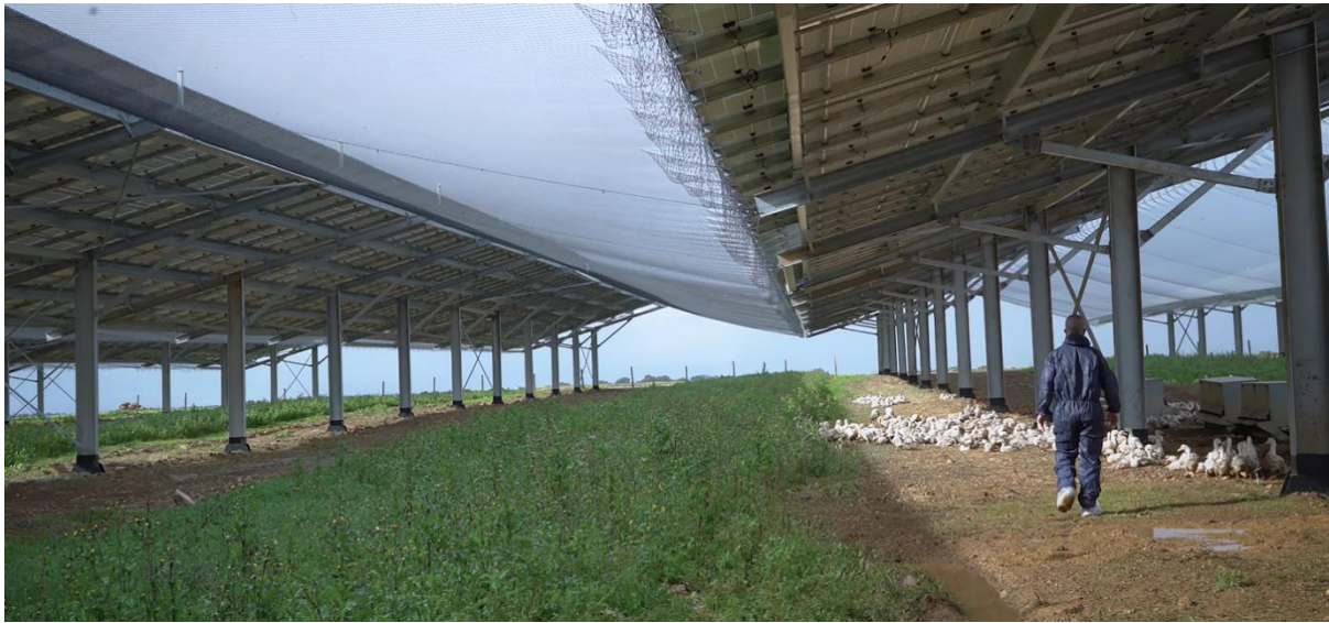
Photographie 4 : Une volière agrivoltaïque développée par Technique Solaire
