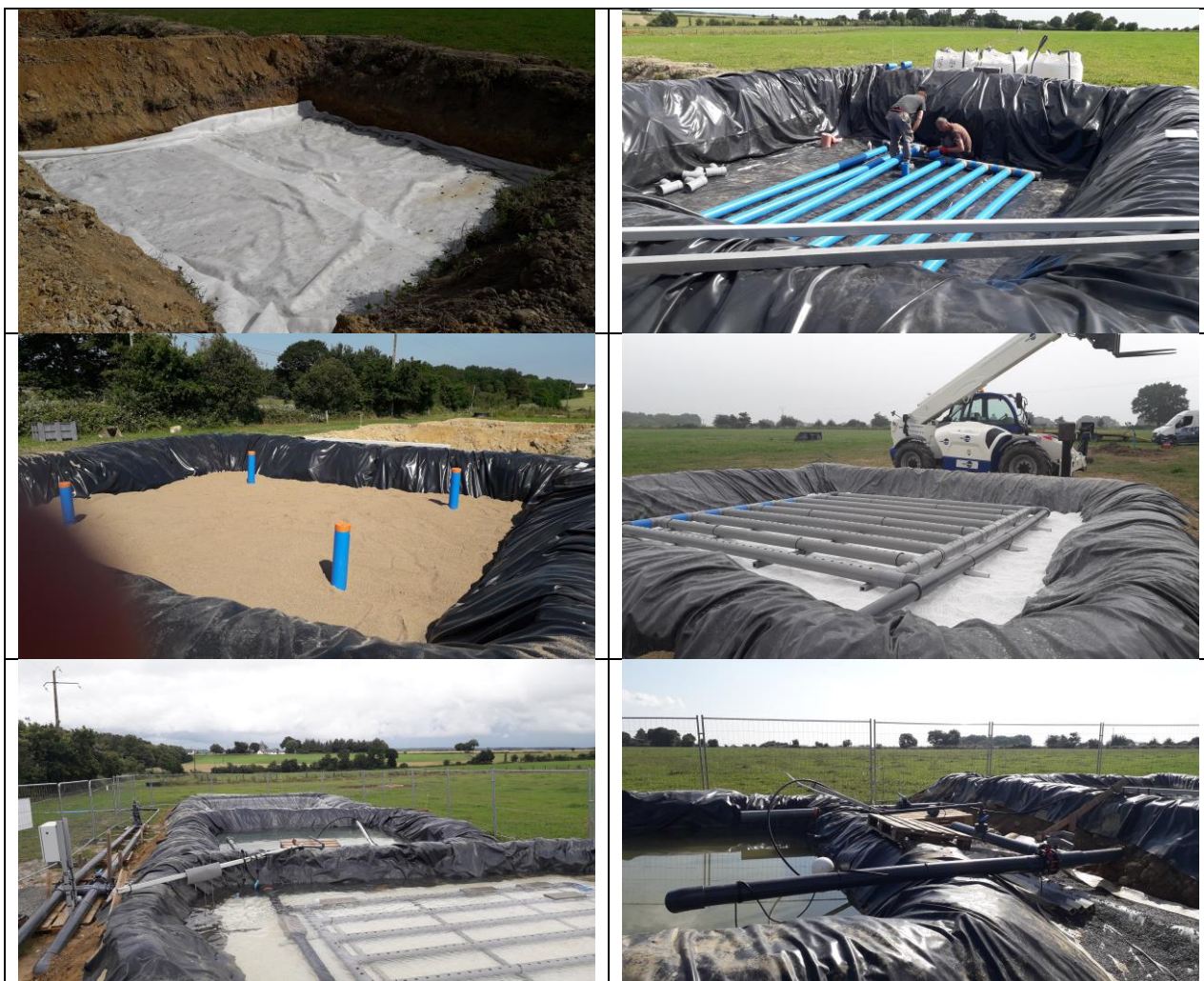
Figure 16 : Photos prises lors de la création de l'unité temporaire de traitement de l'eau pompée
