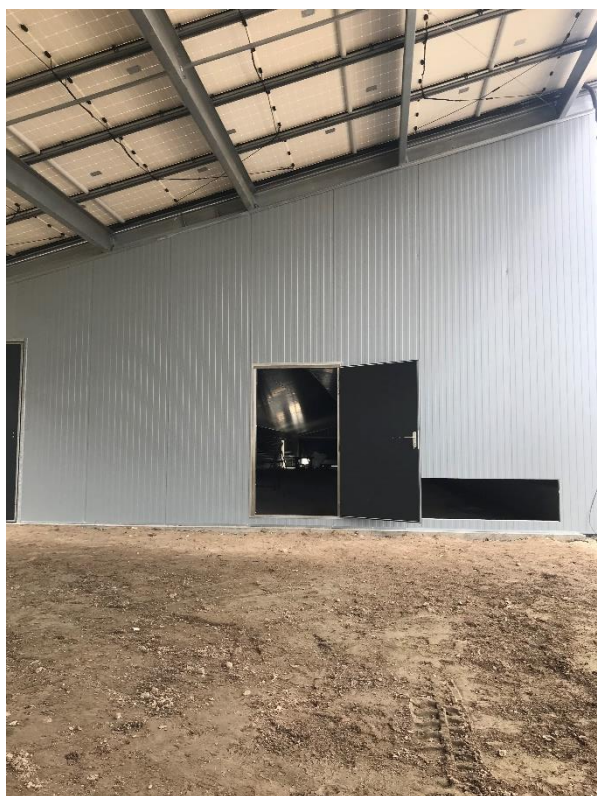
Figure 4 : Rénovation d'un poulailler avec pose de panneaux photovoltaïques en couverture
