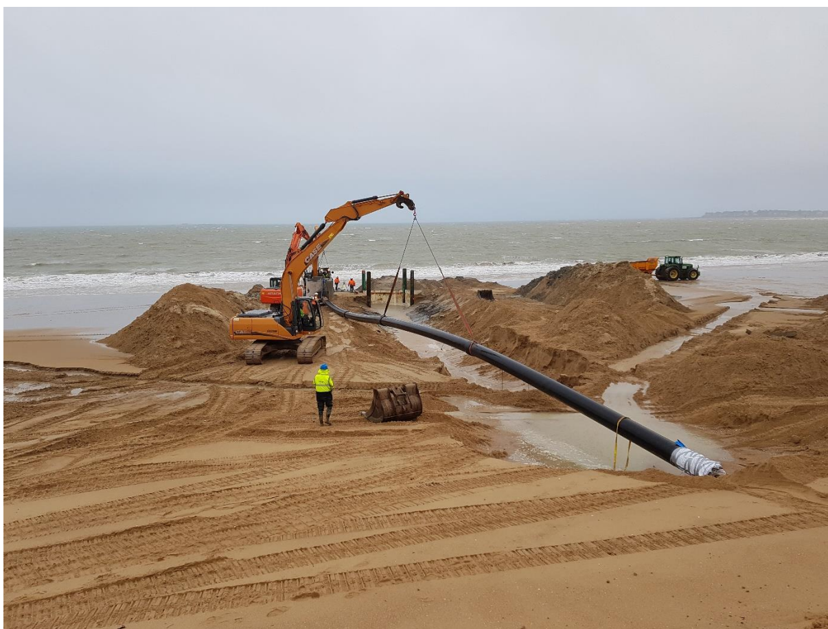
Figure 10 Implantation du refoulement et exutoire à la Baule (2019, 44)
