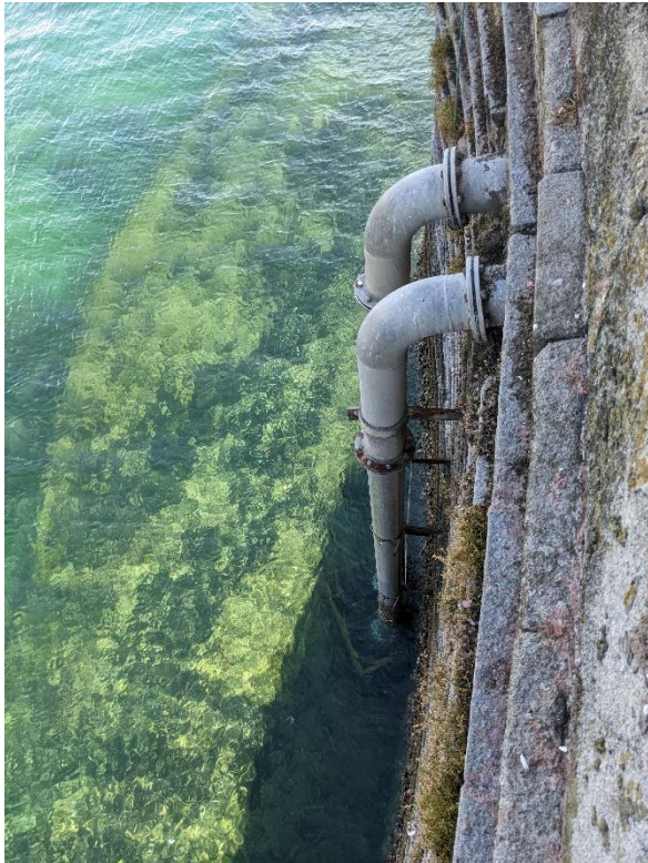
Figure 5 Prise d'eau de mer de la piscine
