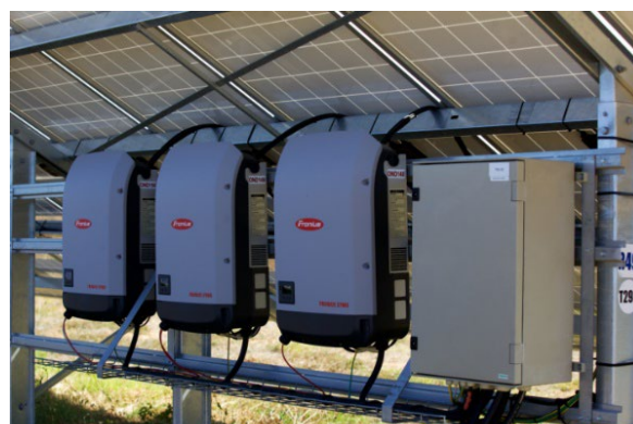
Onduleurs et tableaux électriques
