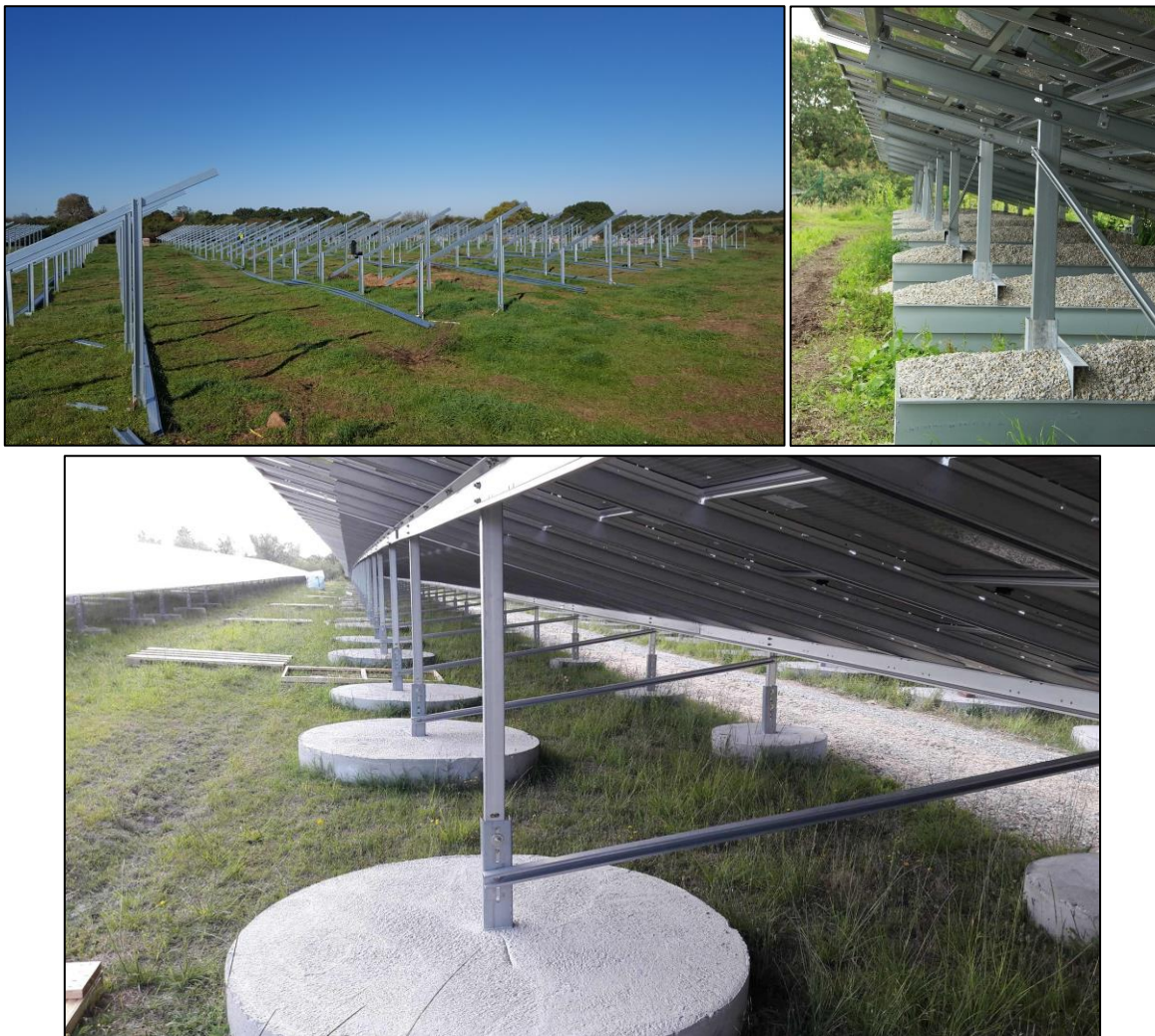
Figure 13 : Mise en place des structures sur pieux battus (centrale JPee de Braize, 03), structures en bac acier (centrale JPee de Questembert, 56) et structures en longrines béton (centrale JPee de Labarde, 33)
