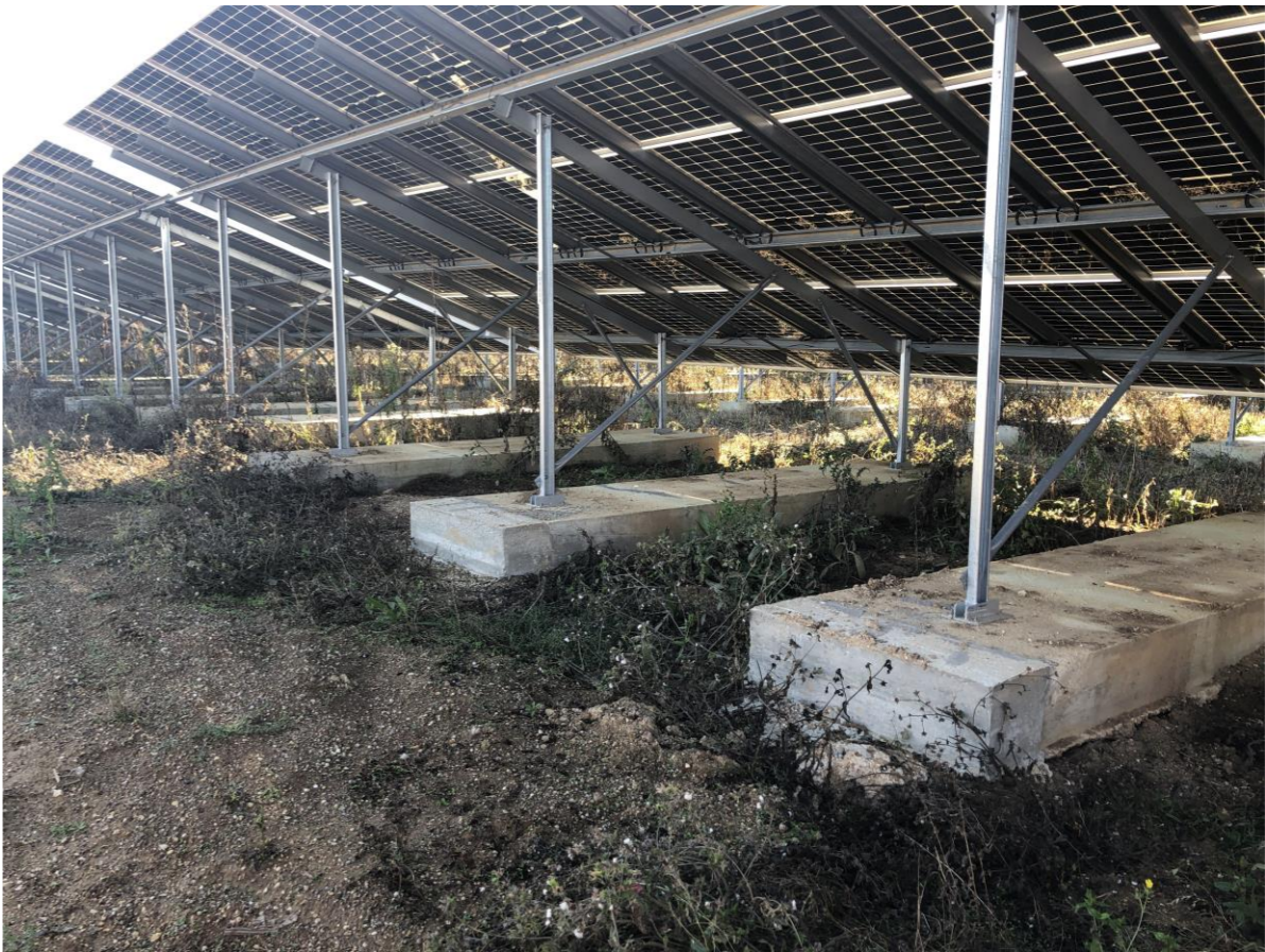
Illustration 2: Exemple de longrines sur la centrale photovoltaïque de Mer (Source : EREA Ingénierie)
