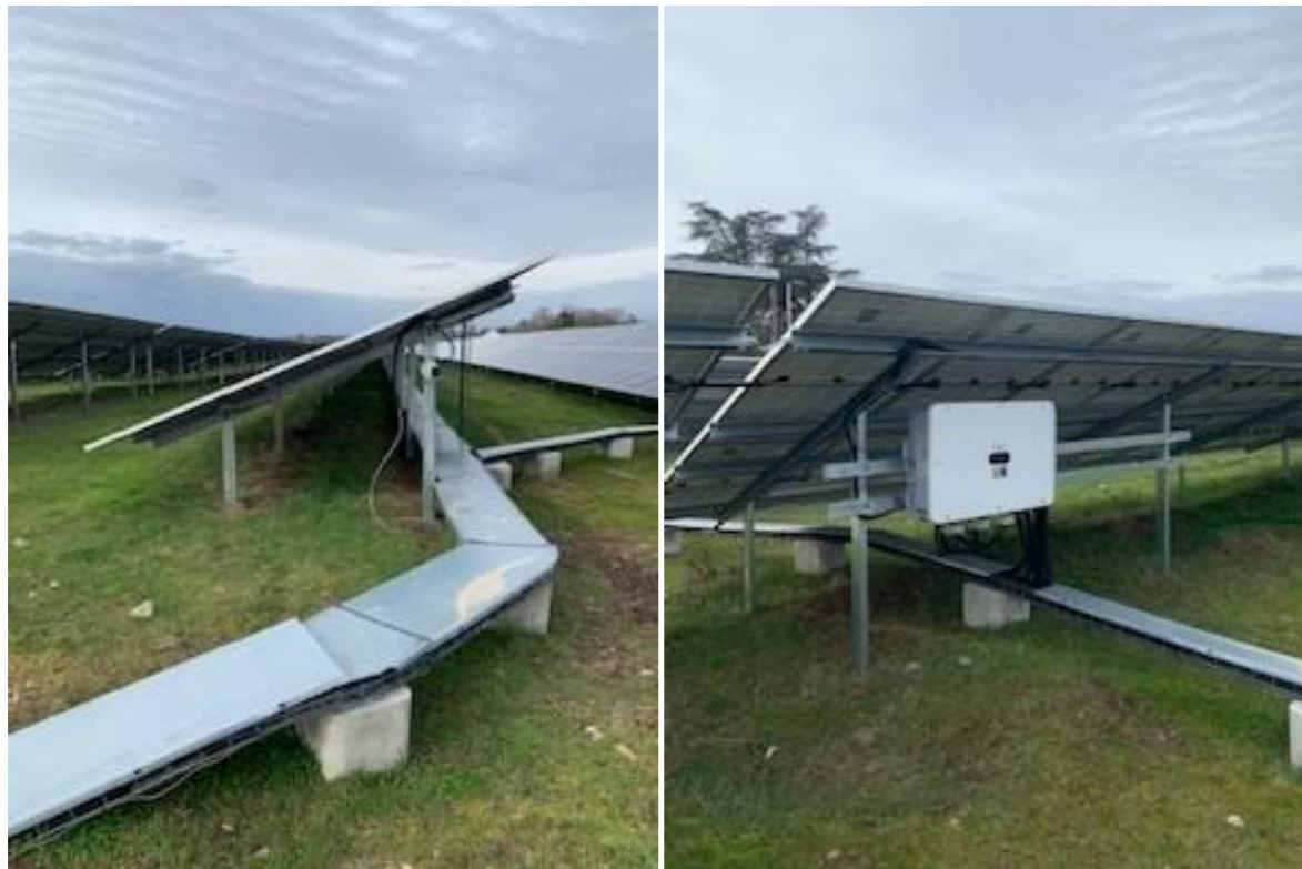
Illustration 3 : Exemple de câblage aérien réalisé sur la centrale photovoltaïque de Salbris (41) (Source : EREA Ingénierie)
