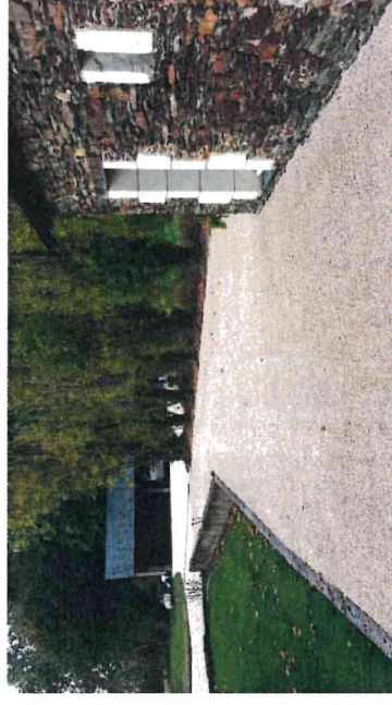
► Un stabilisé renforcé pour les chemins
