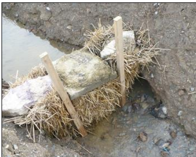
Emplacement de bottes de paille en phase travaux, dans un bassin d'orage et un cours d'eau (DMEAU)
