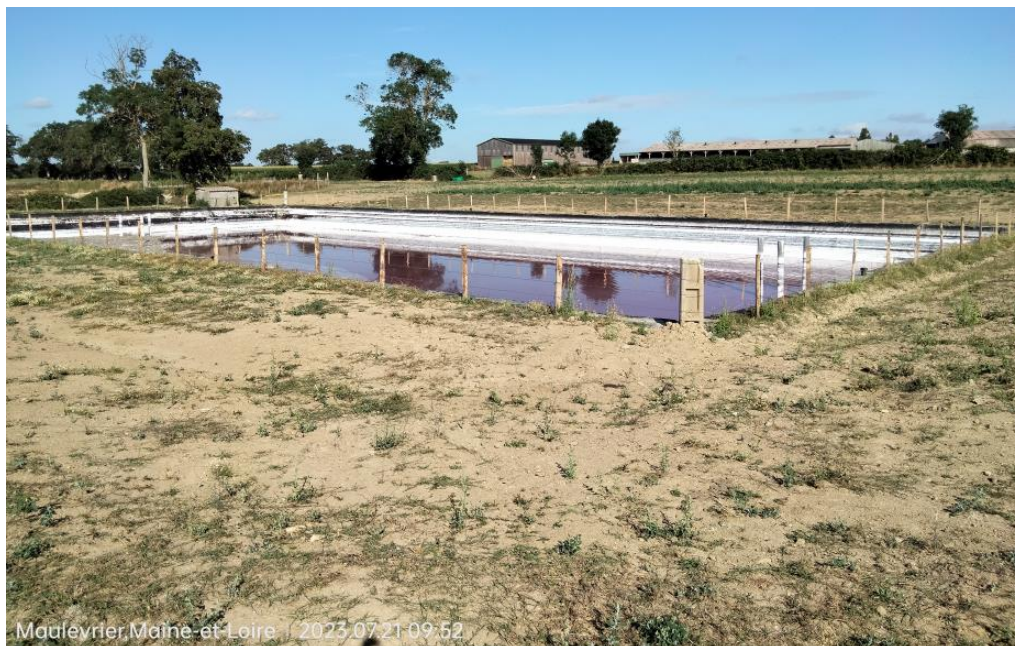
Vue 3 : fosse géomembrane collectant les eaux usées (en arrière plan l'exploitation de la SCEA GABORIT)
