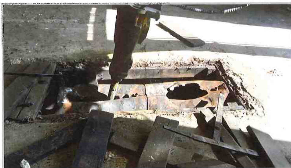
Photo 5 : extraction de la cuve à huile dégazée du garage.
