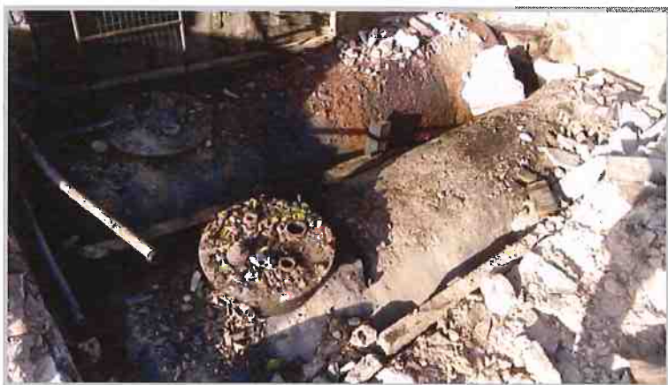
Photo 2 : cuves à fuel mises à jour.
