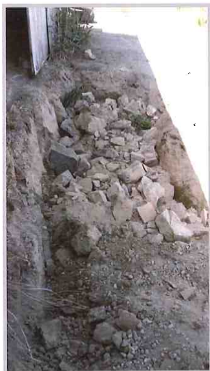
Photo 8 : zone S2 purgée et remblayée.
