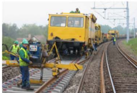
Longs Rails soudés sur traverses béton
