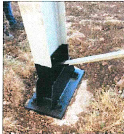
Photos chemins empierrés et platines poteaux sur volières photovoltaïques
