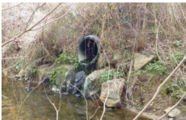
Figure 13 : Photographie du point de rejet des eaux pluviales dans le ruisseau de Liré - © THEMA Environnement
