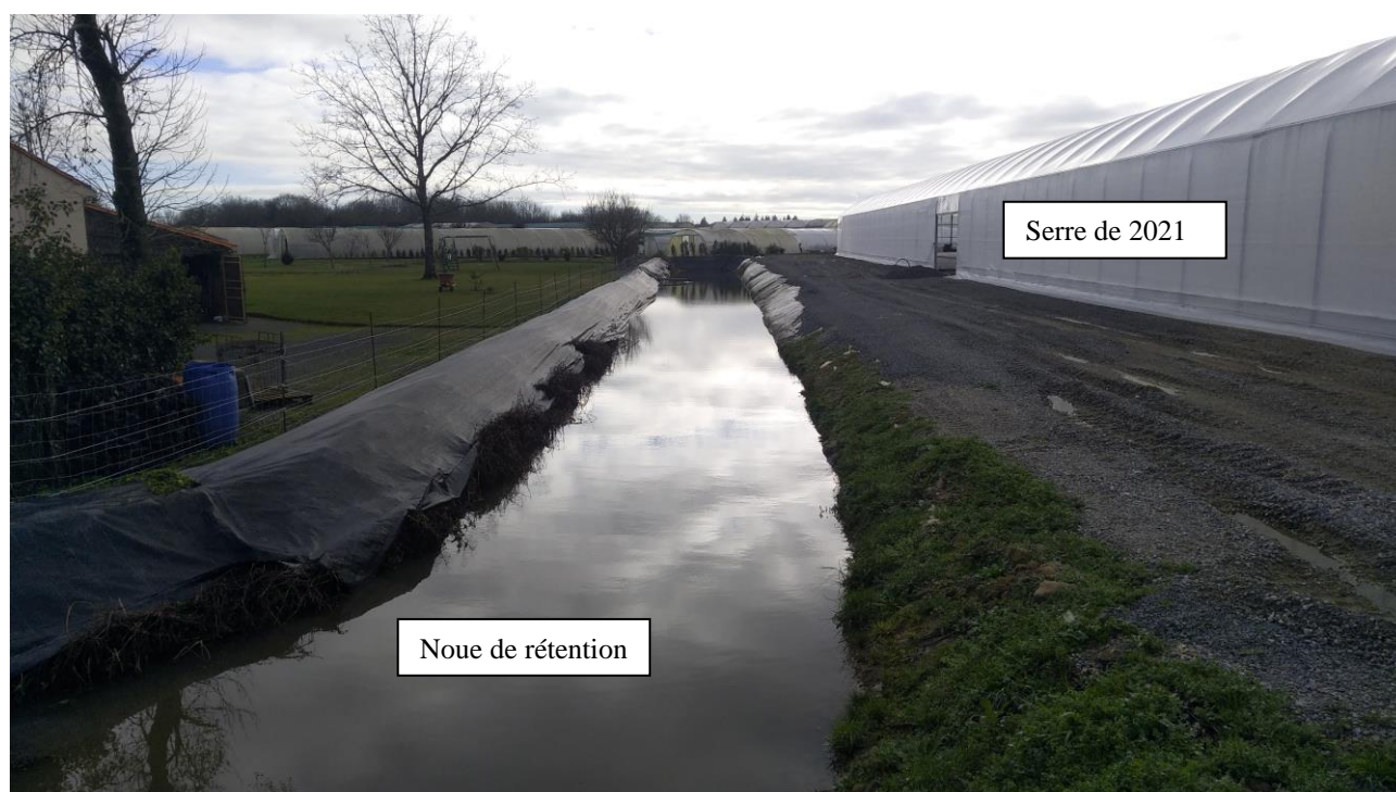
P9 - Photo du bassin de la noue de rétention située sur la partie nord-ouest du site
