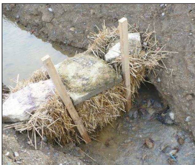
Photo 5 : Emplacement de bottes de paille en phase travaux, dans un bassin d'orage et un cours d'eau
