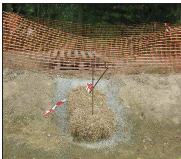
Photo 5 : Emplacement de bottes de paille en phase travaux, dans un bassin d'orage et un cours d'eau
