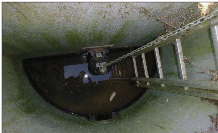
Figure 5 : Exemple d'une vanne à chaînette dans un ouvrage de sortie de bassin d'orage
