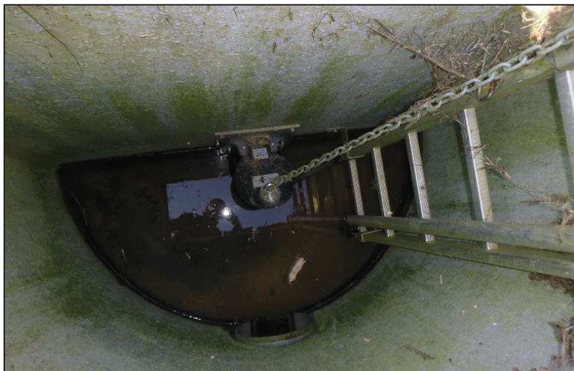
Exemple d'une vanne à chainette dans un ouvrage de sortie de bassin d'orage
