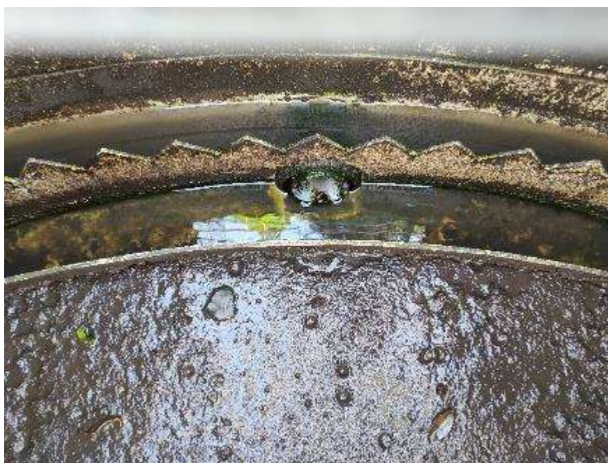
Goulotte de reprise des eaux claires avec un orifice d'évacuation
