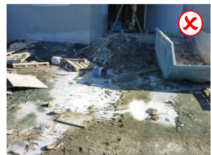
Sol souillé par des déchets et des laitances - Obligation de purge
