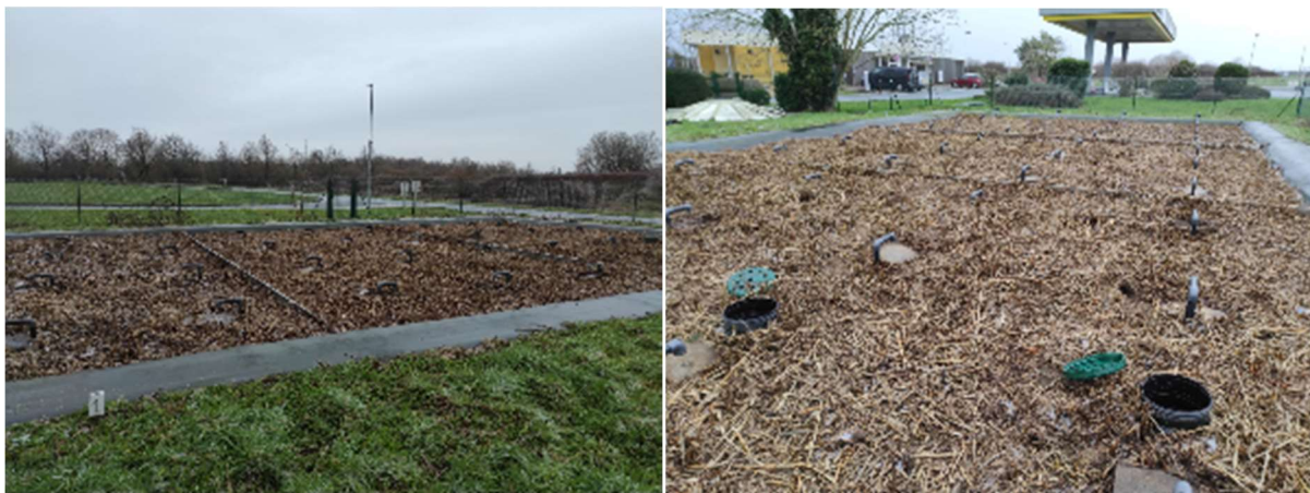
Vue générale du filtre planté de roseaux et ses points d'injection
