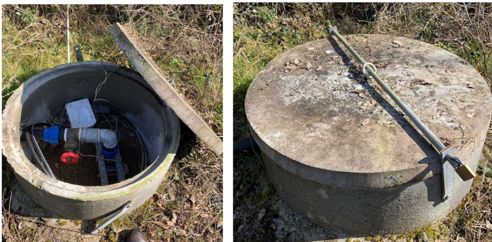
Tête du forage et margelle de protection
