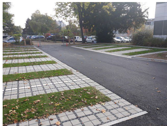
Traitement des stationnement en pavés drainant disposant d'une bande centrale enherbée
