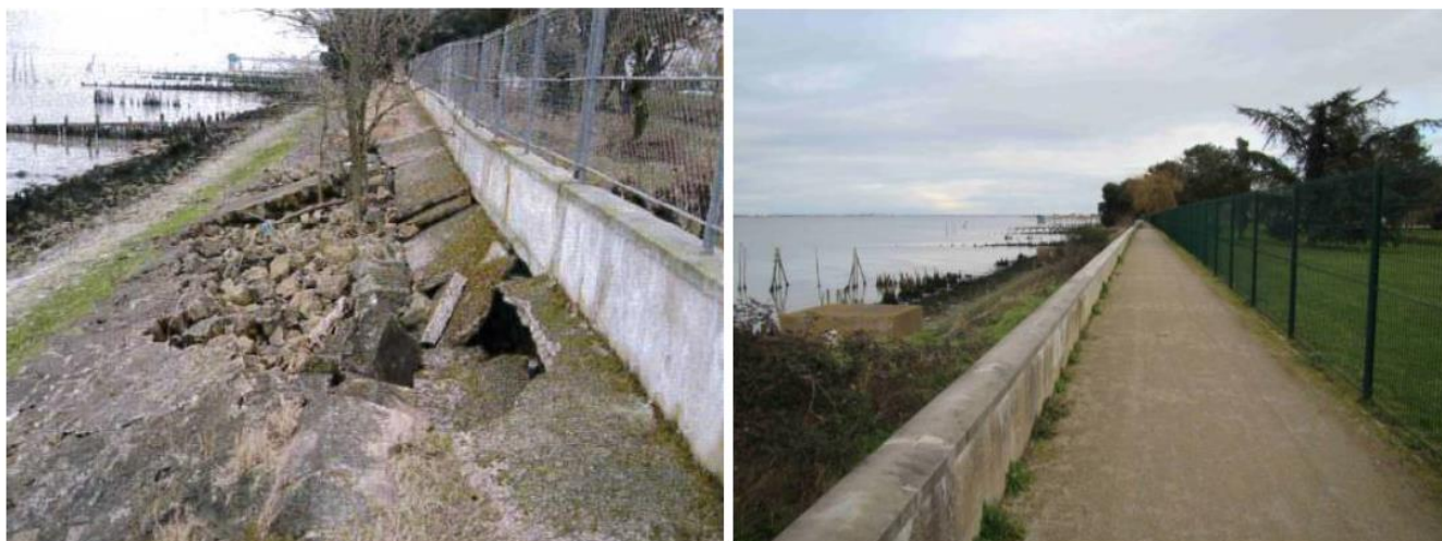
Figure 5. Parement avant et après aménagement de la piste (source : CD44 et ISL)
