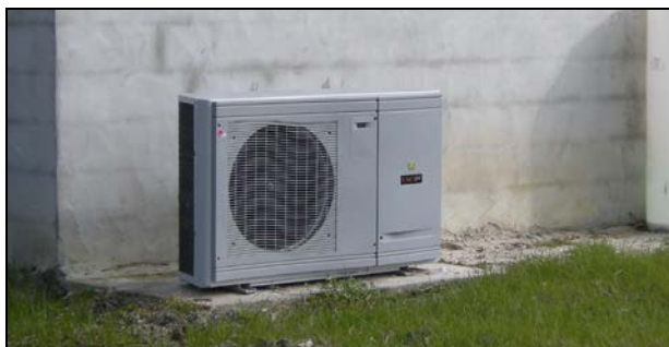
Photo 17 : Pompe à chaleur pour le chauffage de la piscine
