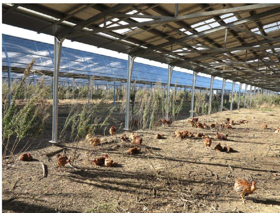
Figure 11 : Exemple d'ombrière photovoltaïque implantée dans un parcours extérieur d'un élevage de volailles
