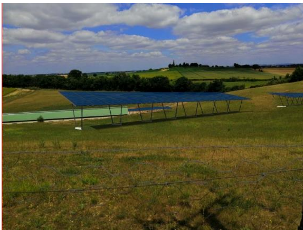
Figure 9 : Ombrière photovoltaïque pour parcours de volailles plein air (doc Novafrance Energy)
