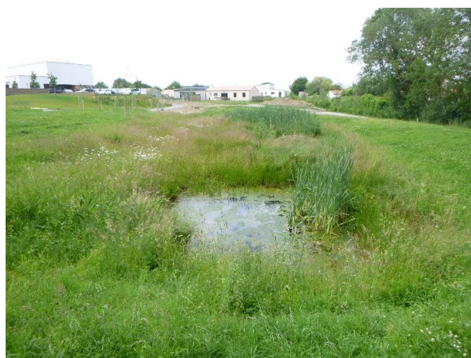
8 : Ouvrage de régulation EP de l'EHPAD et du lotissement « Les Muriers »
