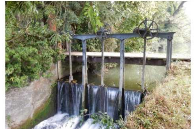
Groupe de 5 vannes de décharge proche de l'île (vue amont) et 3 vannes en rive droite
