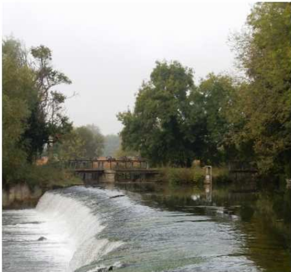
Seuil déversoir en premier plan et groupes de vannes de décharge au second plan
