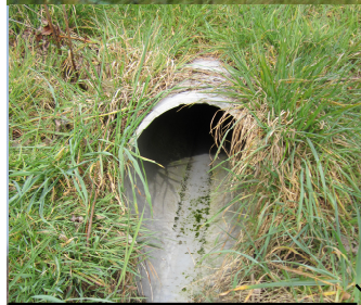
Canalisation d'arrivée DN300 PVC
