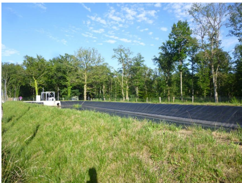
VUE GÉNÉRALE D'UN BASSIN D'EAUX PLUVIALES MULTIFONCTION SEMI-ENTERRÉ AVEC POSTE DE RELÈVEMENT EN ENTRÉE
