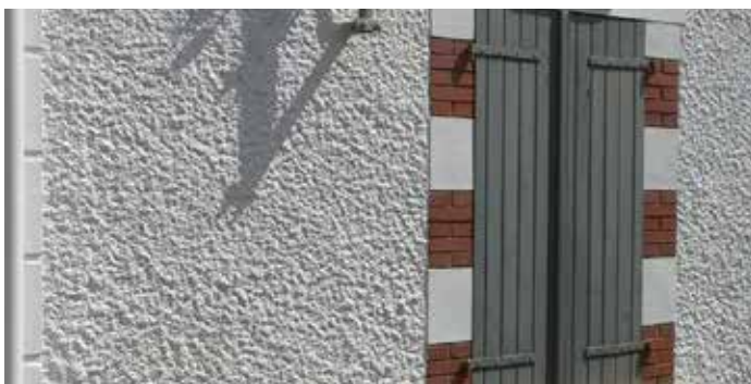
Fig. 8. Enduit à la tyrolienne
