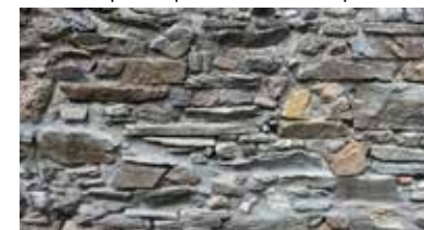
Fig. 15. Mur en moellons Source : A4PLUSA
