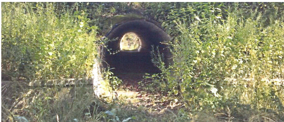
Exemple de passage pour la petite faune sous voirie : cadre ou buse à fond plat
