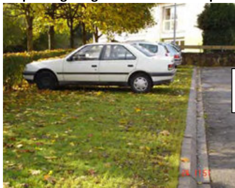
Parking engazonné perméable
