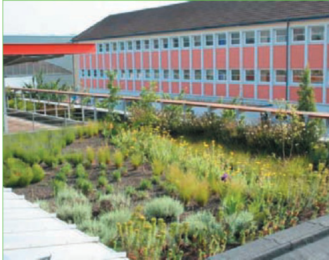
Toiture stockante végétalisée
