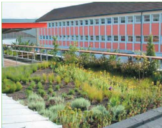
Toiture stockante végétalisée
