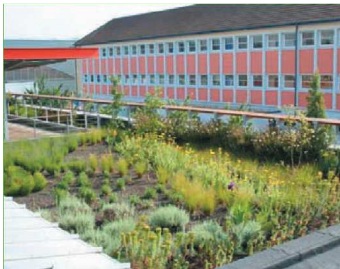
Toiture stockante végétalisée
