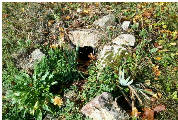
Arrivée Ø 300mm Béton
